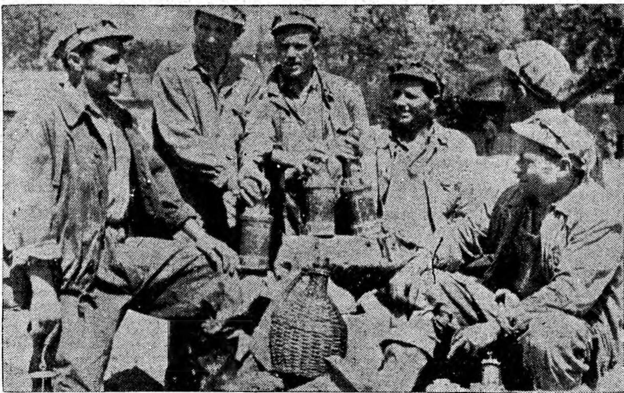
Printre deschizătorii noii mine Dilja se numără și minerii betoniști conduși de tov. Dușan Ioan. Brigada se evidențiază îndeosebi pentru calitatea bună a lucrărilor pe care le execută. ÎN CLIȘEU: Un schimb al brigăzii condus de minerul Roman Vasile, după ieșirea din șut.
