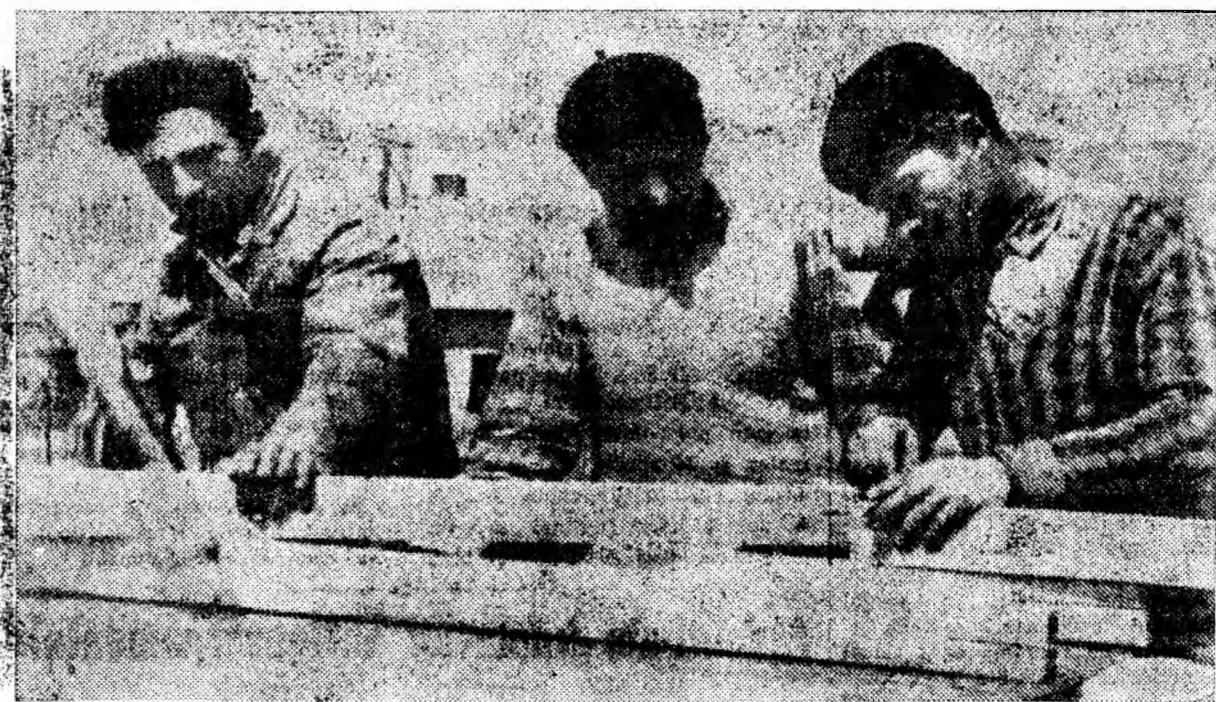
La construcția noilor case de cultură din Petroșani, lucrările se desfășoară din plin. Zilele trecute, a fost turnată placa de beton a parterului. Iată în clișeu pe dulgherii György Ioan, Giurgiu Nicolae și Vișan Sotir confecționînd cofraje pentru turnarea planșului scenei.
