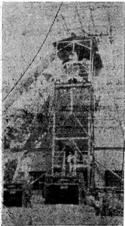
Construcția industrială din clișeu a fost de curînd terminată de I.C.M.M. la mina Dilja. Este turnul metalic al puțului auxiliar nr. 1 care împreună cu instalațiile anexe vor servi la săparea acestui puț după metoda modernă de lucru cu cofraj glisant și pod mobil.
