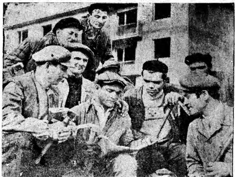
Pe șantierul de construcții nr. 10 din Vulcan, printre brigăzile evidențiate în întrecerea socialistă se numără și brigada de dulgheri condusă de tov. Căplescu Nicolae.
