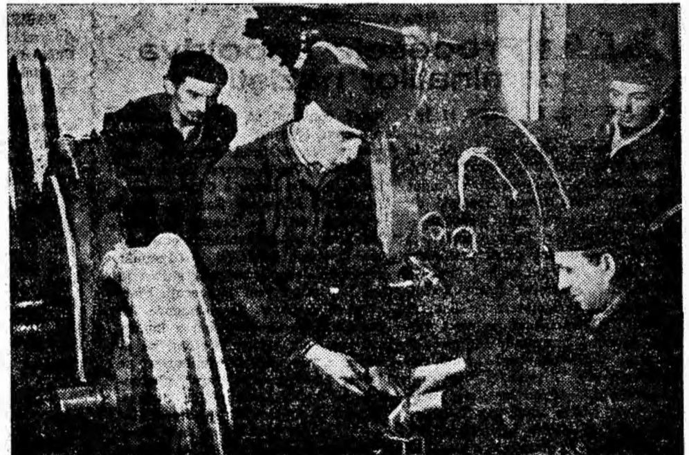
Echipa condusă de comunistul Deatcu Dumitru de la Depoul C.F.R. Petroșani execută reparația unei locomotive cu ridicarea de pe roți. În luna martie, echipa a fost distinsă cu fanionul de evidență în întrecerea socialistă.
