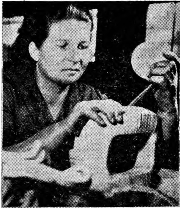
Pricepută în ale meseriei, bobinatoarea Urs Ana de la S.R.E. Vulcan obține rezultate bune în muncă. Iată-o efectuînd bobinarea unui rotor de 20 kW
