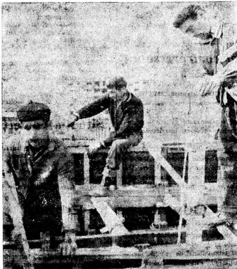
La Petrila se ridică anul acesta 344 noi apartamente. Iată în clișeu pe dulgherii Geamănu Mihai, Cojocaru Pavel și Tughin Victor lucrînd la cofrajele de elevație a blocului E 5 avînd 56 apartamente noi.
