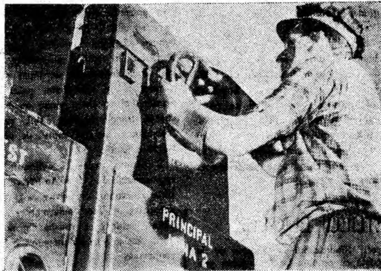
Mereu exemplu pentru colectiv, comunistul Bota Mircea se numără printre electricienii fruntași de la sectorul 9 al minei Vulcan. Iată-l în timpul lucrului — cuplînd linia de 6 kV între puțurile 8 și 7 vest Vulcan.
