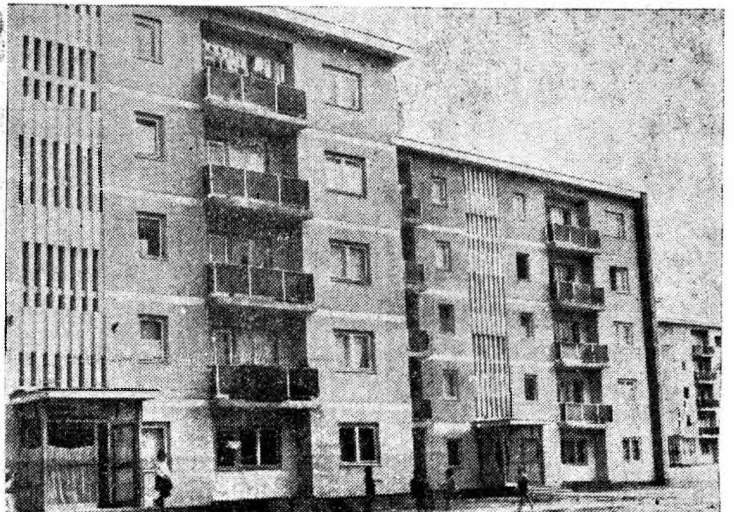
Zilele trecute, pe șantierul Livezeni s-a predat blocul B 11 avind 40 apartamente frumoase și spațioase. Este al cincilea bloc de pe acest șantier predat în acest an. Iată o vedere a noului bloc, care și-a primit deja locatarii.
