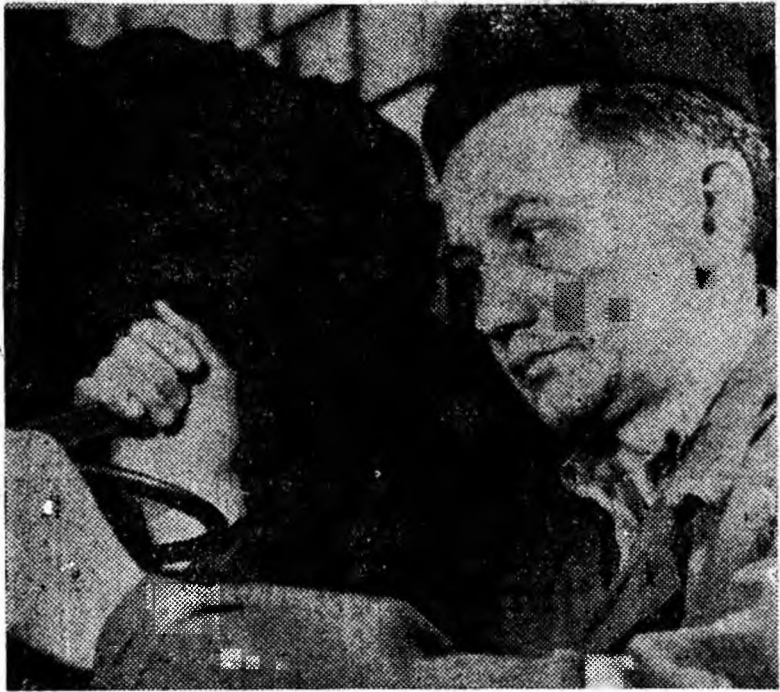
Fotoreporterul nostru l-a surprins în obiectiv pe șeful de echipă Foro Iosif din sectorul electromecanic al minei Petrila făcând verificarea unui compresor de aer comprimat de 45 m 3 /minut.
