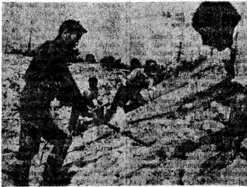
Brigada de zidari — pietrari condusă de Balaite Pavel de pe șantierul de la Petroșani al T.C.M.C. se bucură de o binemerită apreciere datorită calității și randamentului pe care le obține la lucrările executate.
