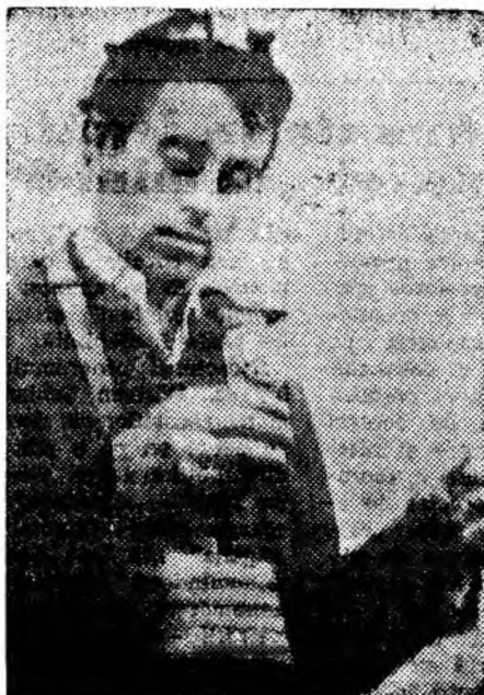
Masca de autosalvare se folosește numai pentru reținerea oxidului de carbon, care poate apărea în cazul incendiilor, focurilor sau exploziilor în subteran.
