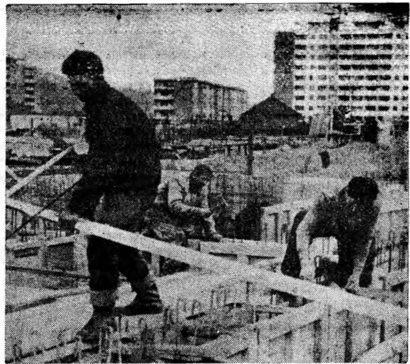
Dulgherii din echipa condusă de comunistul Marin Nicolae de la șantierul din Vulcan ocupă un loc constant printre fruntașii șantierului. Iată-i lucrînd la cofrarea elevației blocului F 8.
