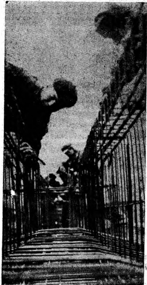
În incinta minei Vulcan, constructorii șantierului T.C.M.M. au început fundațiile unui obiectiv industrial: noul atelier mecanic al exploatarei Vulcan. ÎN CLIȘEU: Fierar-betonistii șantierului montează armătura metalică a fundației atelierului.
