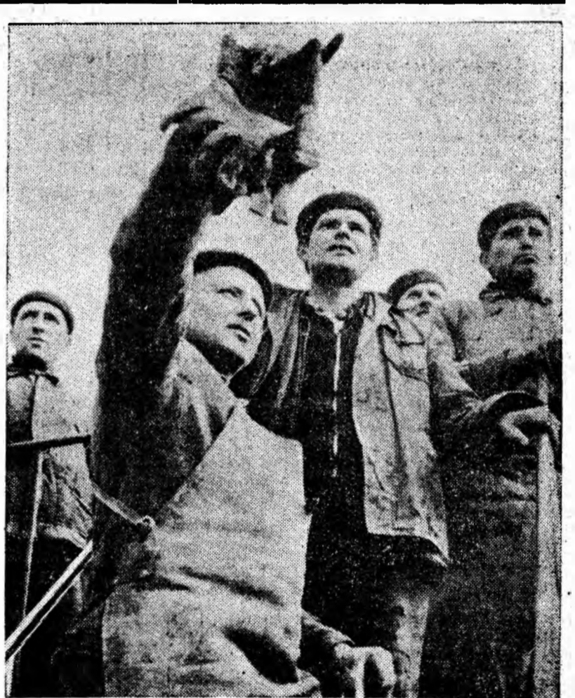
Optimismul sudorilor, lăcătușilor și montorilor din brigada lui Stegaru Ionită e pe deplin justificat. Depășirile de plan de peste 20 la sută pe care le obțin fac ca aducțiunea de apă necesară minei Petroșeni să înainteze mai repede. Foto: N. Moldoveanu
