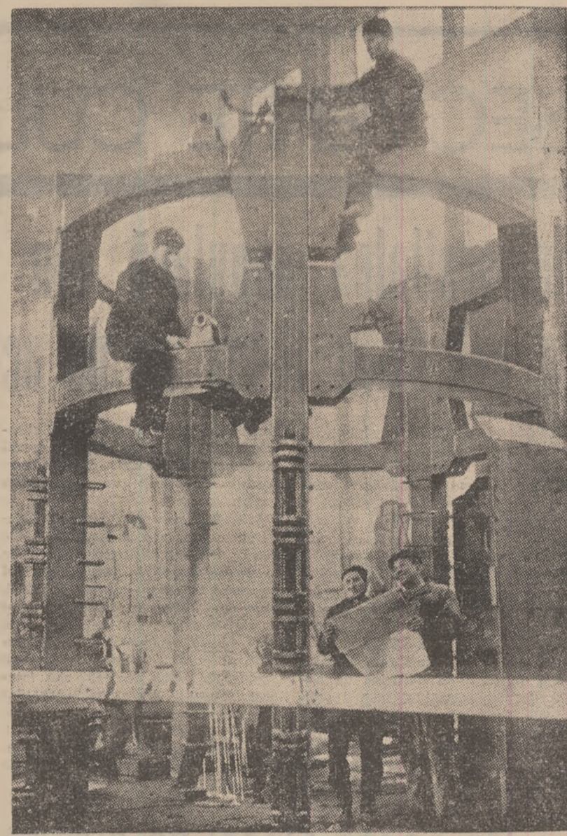
În secția construcției metalice de la UR.U.M.P., brigada condusă de lăcătușul Heinz Eugen asamblează un cofraj mobil pentru mina Livezeni.
