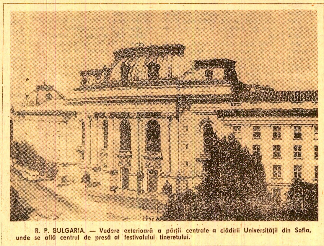
R. P. BULGARIA. — Vedere exterioră a părții centrale a clădirii Universității din Sofia, unde se află centrul de presă al festivalului tineretului.
