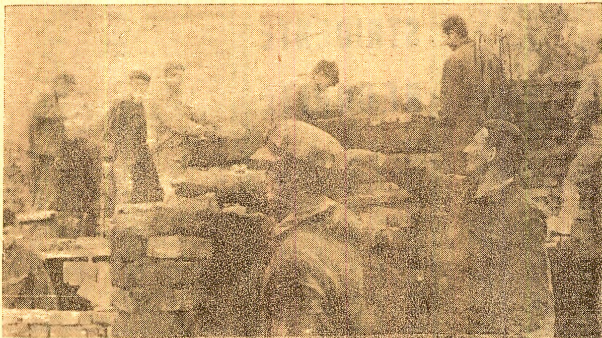
La Vulcan își înalță silueta un nou obiectiv — blocul nr. 27. Echipa de zidari condusă de Ban Ștefan care lucrează aici își depășește lună de lună sarcinile de plan.
