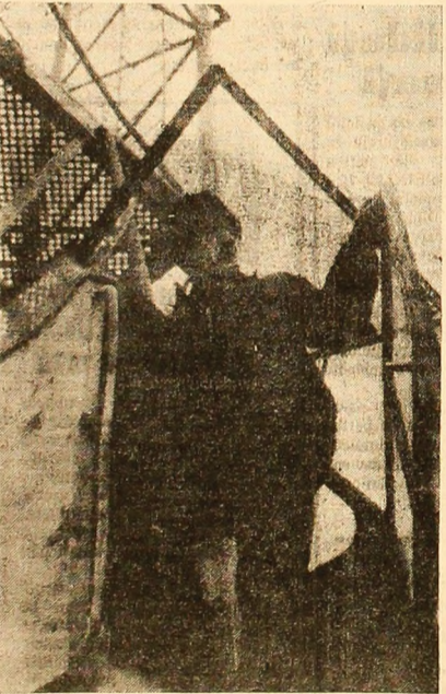
La Corcoșii, este în plină construcție o modernă fabrică de brichete din cărbune.
