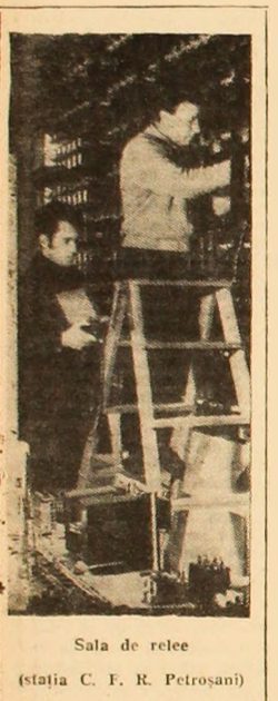
Sala de rele (stația C. F. R. Petroșani)
