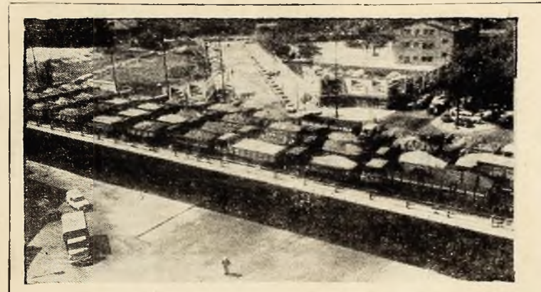
SPANIA: În foto: 900.000 kg pe un pod 50 de autocamioane încărcate cu 900.000 kg nisip pe oază rezistentă unei autostrăzi suspendată pe piloni, construită peste străzile Francisco Silitva și Joaquin Costa din Madrid. După trecerea examenului de rezistență autostrada a fost deschisă traficului.
