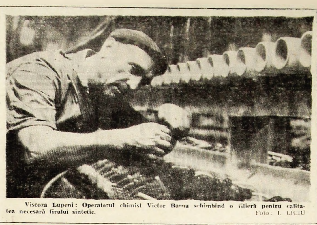
Viscoza Lupeni: Operatorul chimist Victor Barna schimbând o filieră pentru calitatea necesară firului sintetic.
