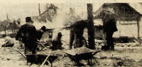
Recent, constructorii șantierului din Petroșani au terminat lucrările de bordură
