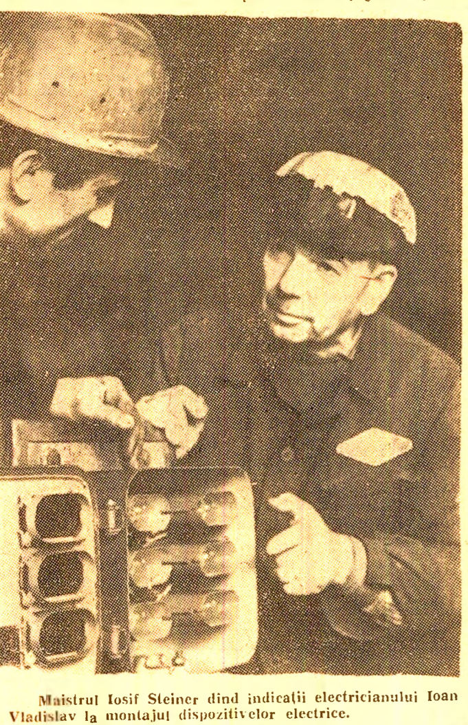
Maistrul Iosif Steiner dînd indicații electricianului Ioan Vladislav la montajul dispozitivelor electrice.
