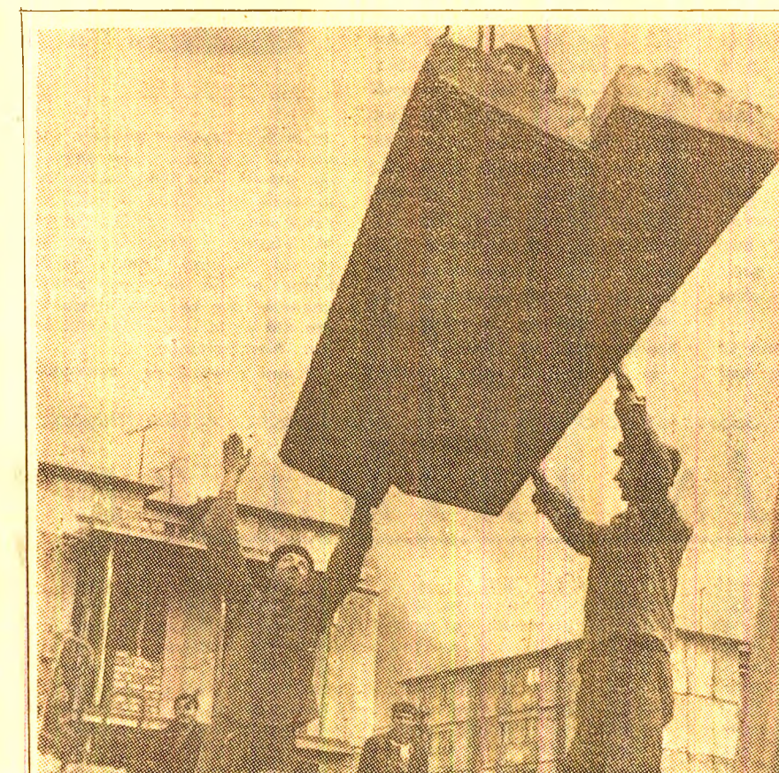
MAI LA DREAPTA!... Noi elemente prefabricate de beton își ocupă locul în zidurile blocurilor ce se înalță în cartierul Aeroport
