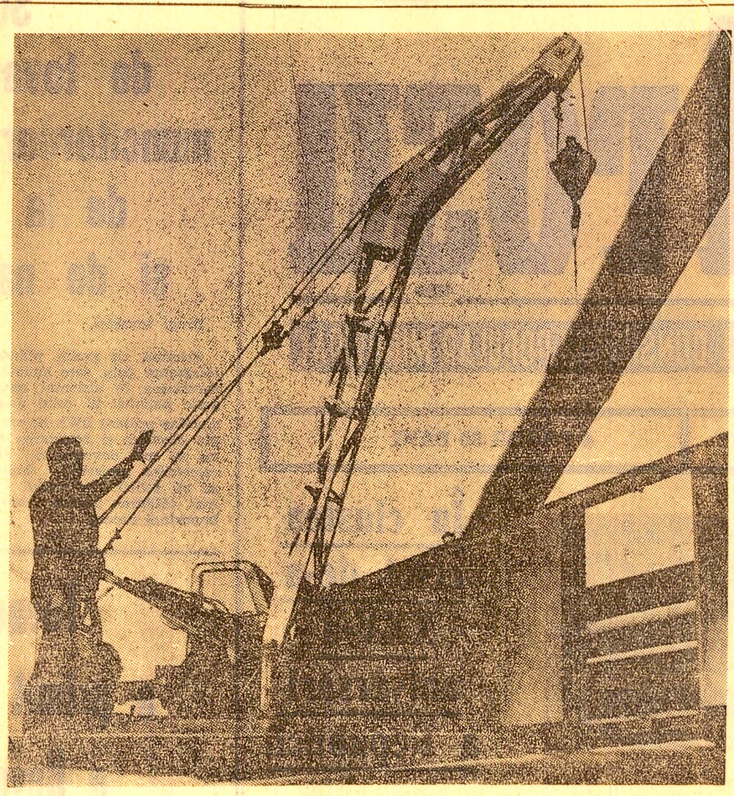
Pe rampa gării Livezeni. Se descarcă un nou lot de țevi pentru șantierul 5 instan- lații — Petroșani. Foto: Ion LEONARD
