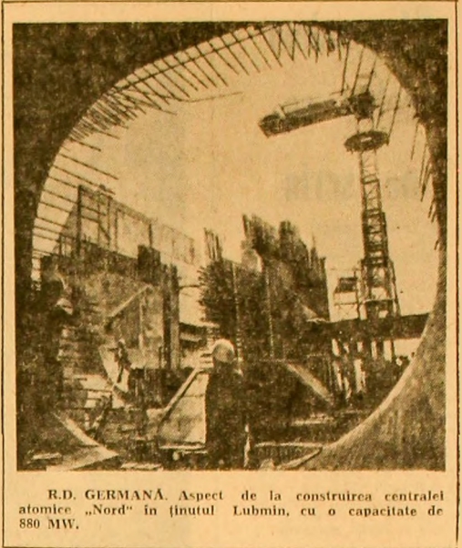
R.D. GERMANĂ. Aspect de la construirea centralei atomice „Nord” în (ținutul Lubmin, cu o capacitate de 880 MW.
