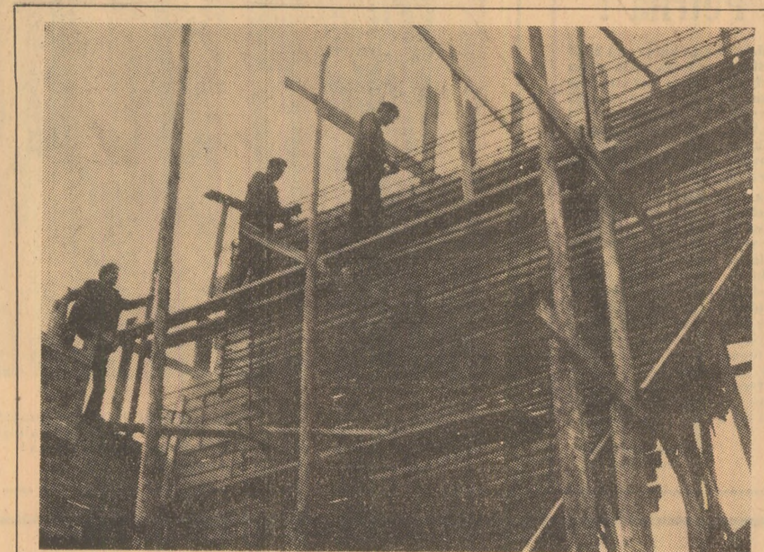
Pe schele pasarele care face legătura între șoseaua principală, viitorul cartier al Livezului și modernul complex mîiner - am surprins pe șeful echipei de lierari Imre Toth și dulgherul Tânase Ștef și Tudorică Lupu... la „înălțime” lucrînd la cofragul viitorului picior de beton al pasarelilor.
