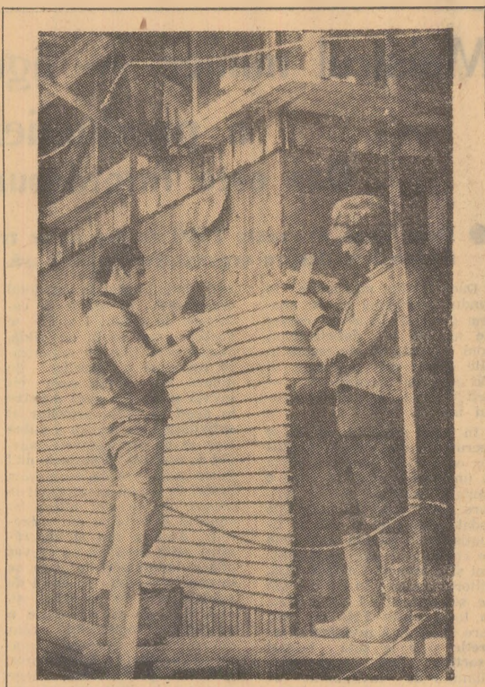
Blocul turn din cartierul Aeroport este aproape pe terminate. E rezultatul hărniciei zidarilor conduși de brigadierul Dumitru Postolache care, prin depășirea zilnice a sarcinilor de producție au reușit ca într-un timp mult mai scurt să ajungă la ultimele nivele ale clădirii. În cliseu, am surprins doi din zidarii care execută placarea fațadei blocului G 1-2: Ion Postolache și Ion Postolache II.
