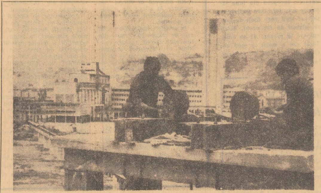
Într-un cadru de un pitoresc industrial am surprins pe tinerii muncitori Aurel Ghiban și Ion Pleșcan în timpul execuției lucrărilor la stația de prelungire a benzii de 300 m. — bandă care va transporta stîrjile de la complexul minier la halda de peste Jiu.
