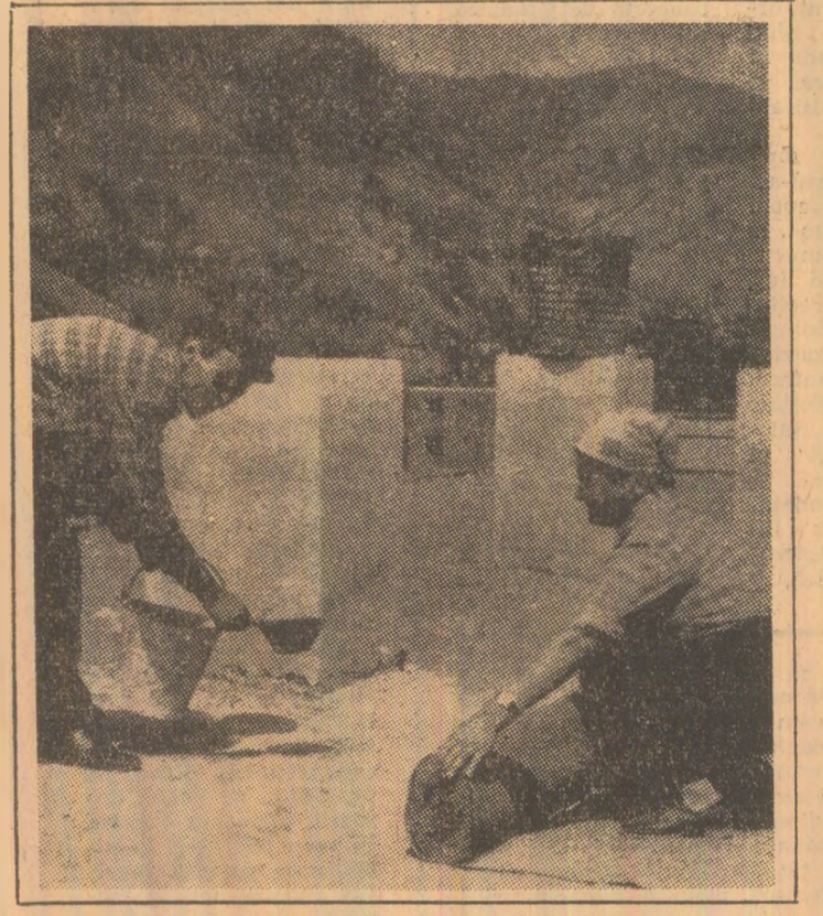
Ultimele lucrări de izolare la terasa unui nou bloc.
