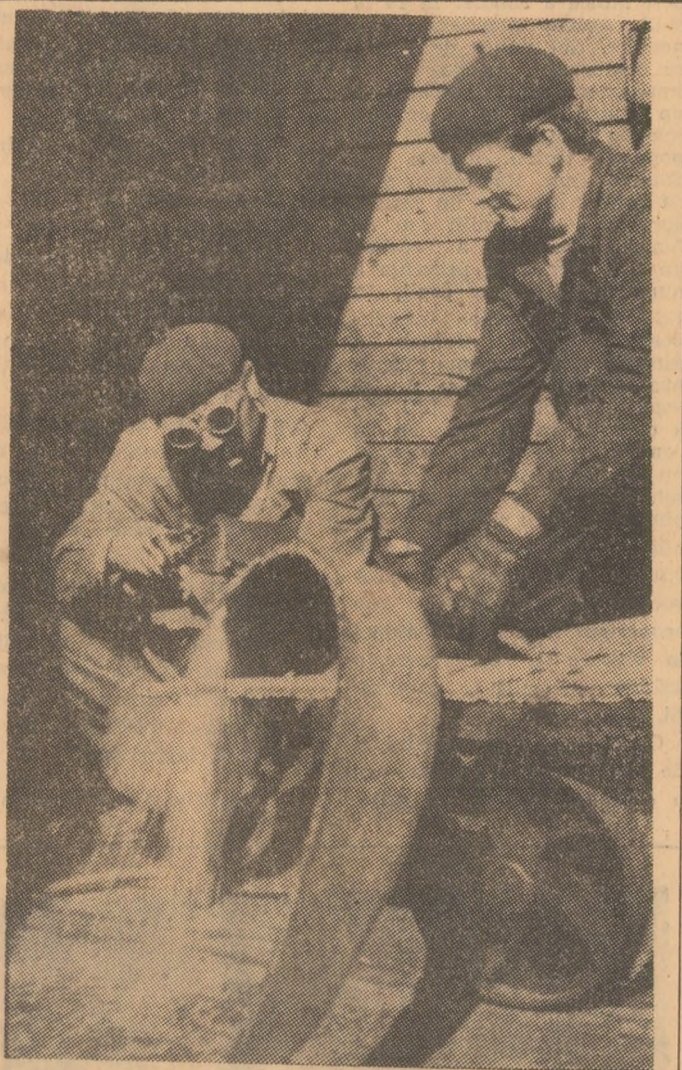
Comunistul Ion Băjenaru — unul din sudorii de nădejde ai atelierului mecanic al minei Lupeni și tinărul lăcătuș mecanic Dumitru Giura — doi membri din vreadnică echipă condusă de Anton Duban lucrînd la modificarea unui tambur de la combina 2K-52.
