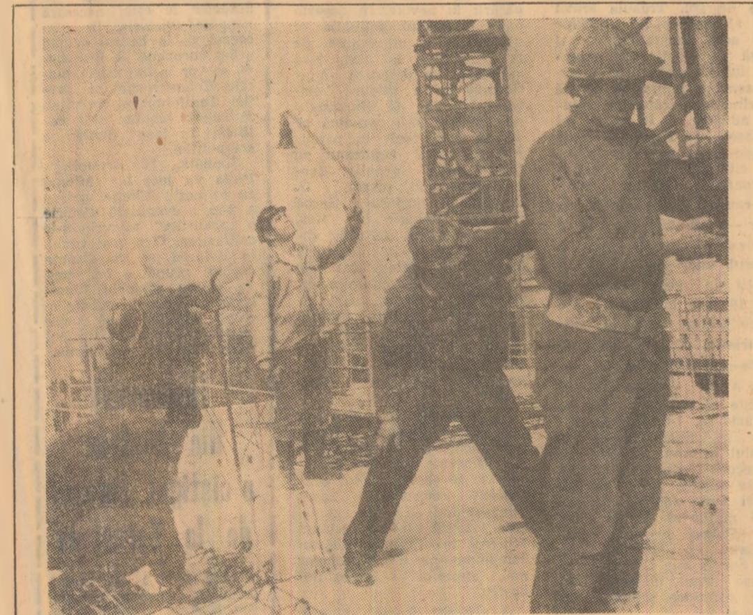
Construcții blocului turn A1 din Vulcan, primul bloc din Valea Jiului executat prin noua tehnologie de turnare a pereților de rezistență prin intermediul cofrajelor plan universale, au atins cotă finală. Iată-l pe montorul din echipa condusă de Constantin Ebinică pregătind operația de turnare a betonului la ultimul nivel al blocului.
