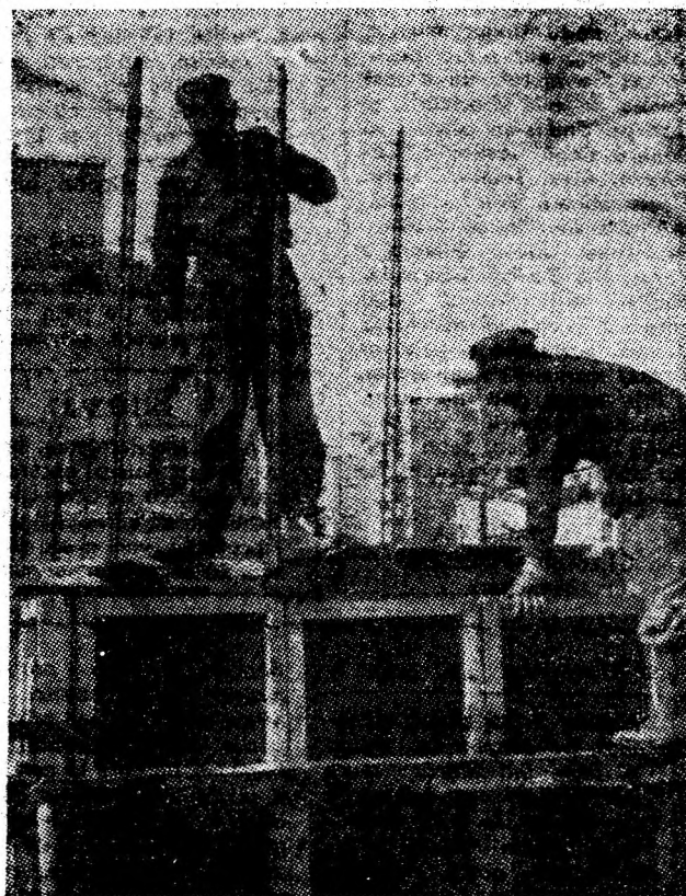
Dulgherii Dumitru Scornea și Ion David din brigada condusă de George Neagoș au început lucrările de fundație la cota zero a noului bloc 69 din viitorul centru civic al Petroșaniului.
