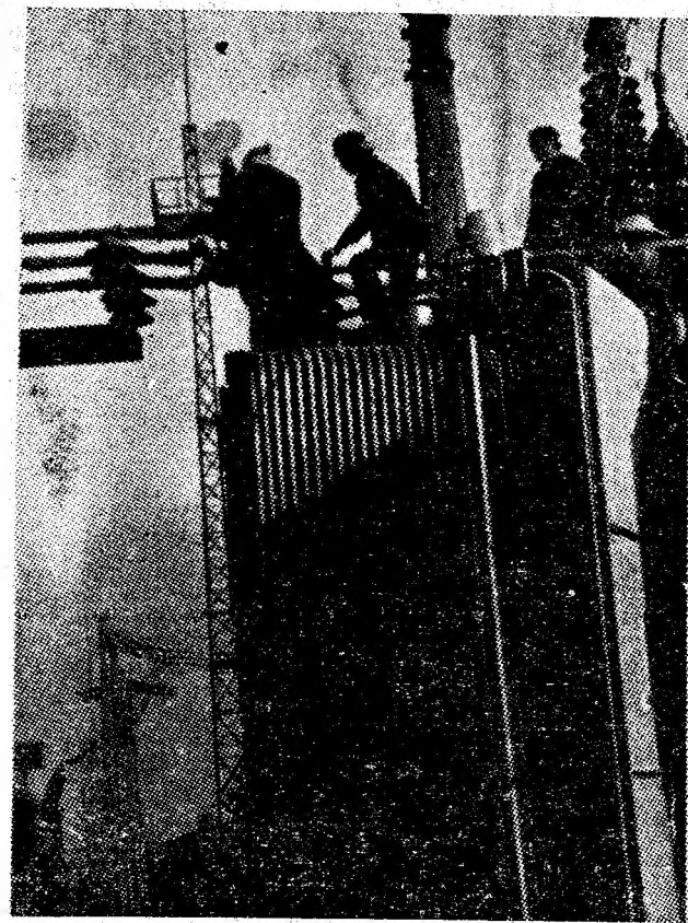
U. E. Paroșeni. Echipa de electricieni condusă de comunistul Ion Dărăban, executînd revizia transformatorului 60 MVA.
