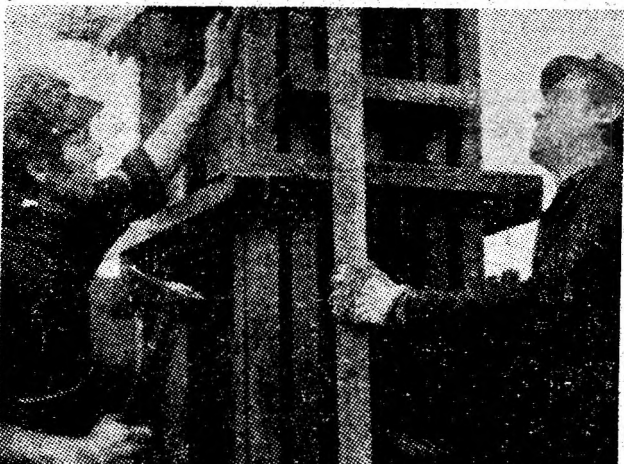
În aceste zile de septembrie pe șantierele Vulcanului, dulgherii Milică Tăbăcaru și Mihai Tirnăveanu din brigada lui Gheorghe Savin montează cofrajele metalice la blocul 3 din viitorul centru civic al orașului.
