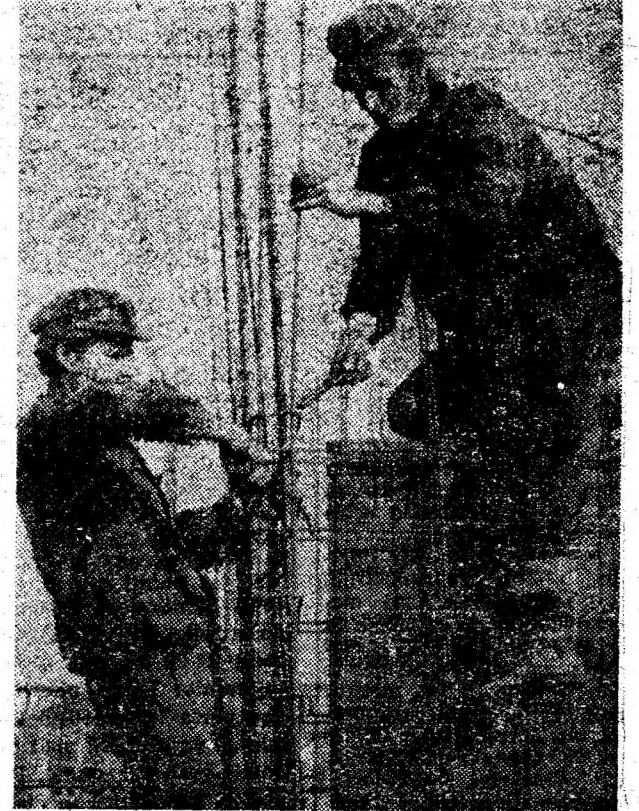
Fierar-betonistii Iosif Demița și Ion Iașeu, din brigada lui Ludovic Horvath instalează armătura etajului IV de la noul bloc 69 din viitorul centru civic al Petrosaniului.
