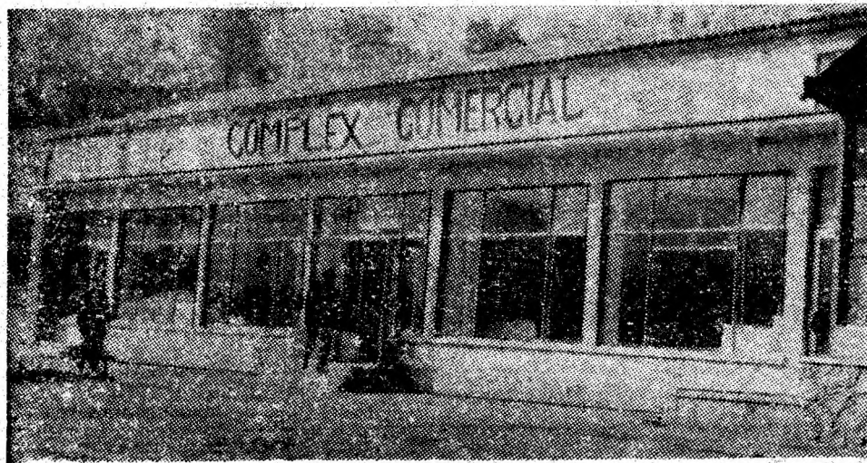
Noul complex comercial din comuna Bănița.
