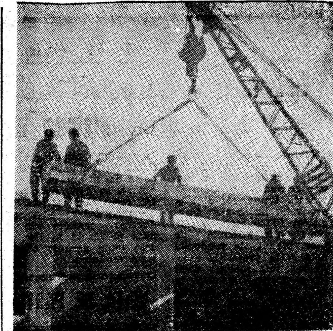
Montoriș din echipa lui Ștefan Augustin execută lucrări la stația filtre-presă a Preparației Coroști.
