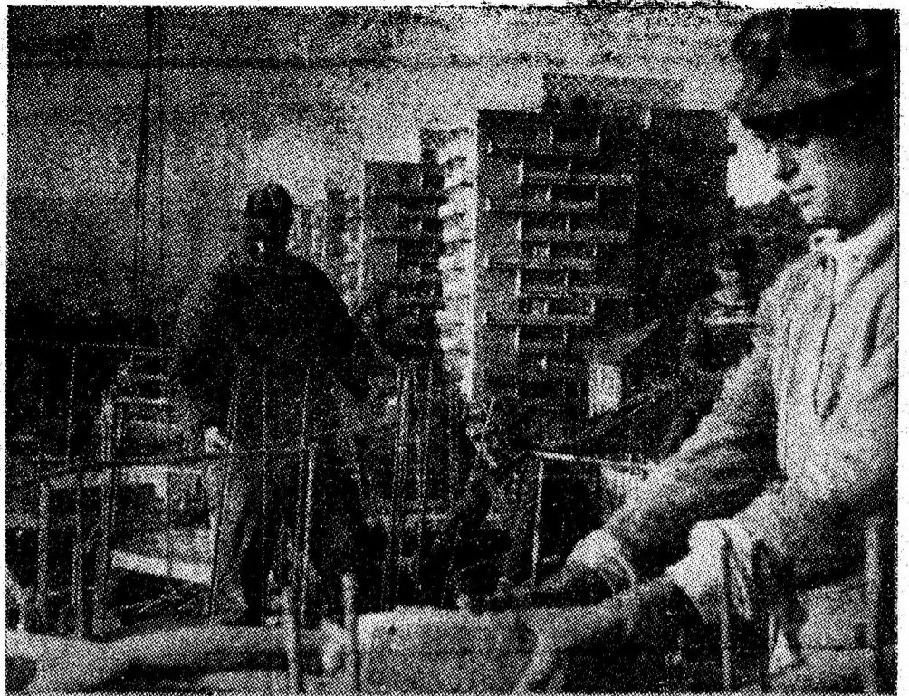
În toate orașele municipiului nostru se construiește într-un ritm intens. În noul centru al Petroșaniului în ultimii ani au apărut numeroase blocuri de locuințe. La multe dintre acestea a lucrat și echipa condusă de dulgherul Gheorghe Neagoe. În imagine, aceeași echipă ridică un nou tronson din blocul 69.
