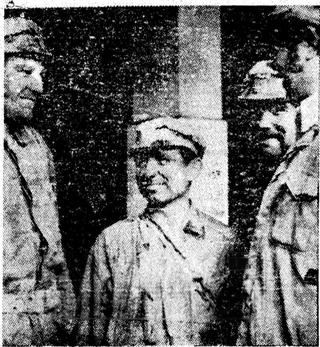
Brigadă destoinică la lucrările de pregătire a sectorului IV — Petrița, cea condusă de Francisc Kovacs. Plusul de la începutul anului: 150 ml. Foto: Ion LICIU
