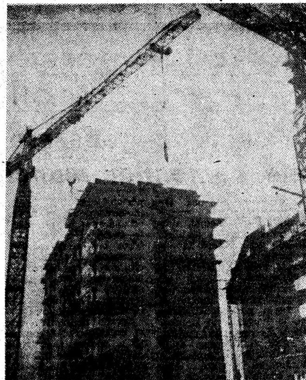
Centrul Petroșaniului se dezvoltă în acest an cu noi blocuri de locuințe, elemente de preț ale confortului și modernului urban. Numai în această zonă de locuit se vor executa peste 250 noi apartamente pentru oamenii muncii ai municipiului.
