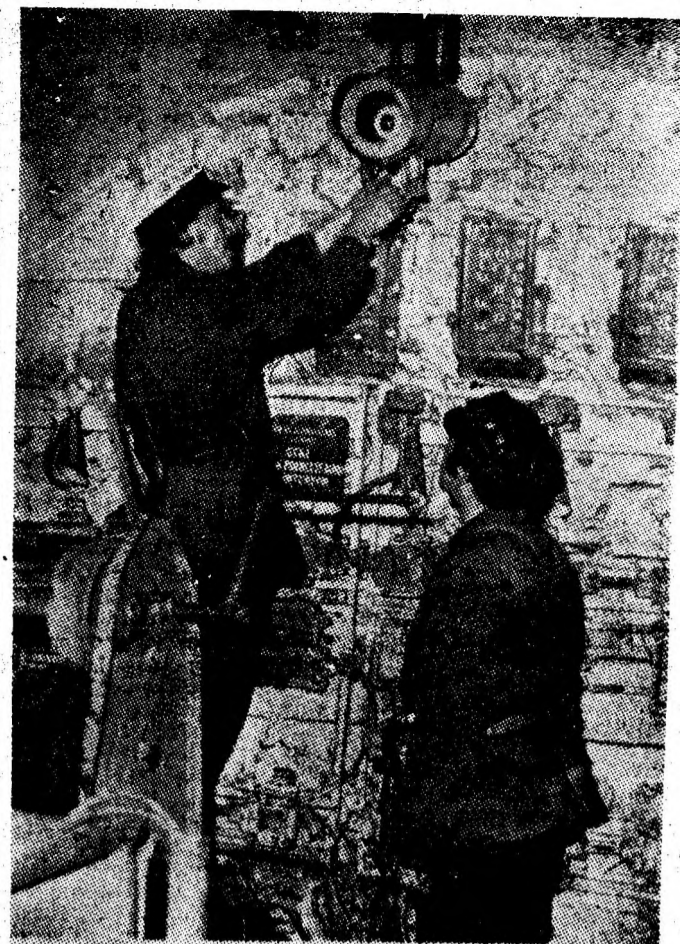
Noile cuceriri ale progresului sînt prezente elocvent în munca minerilor Văii Jiului. Fotografia reprezintă un aspect din timpul verificării funcționării corecte a camerei de luat vederi, instalată la stația benzii nr. 20 pentru urmărirea televizată a producției la I. M. Petroșani.
