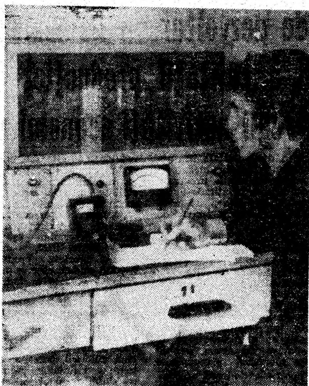
Tinărul montor de aparate de măsurat gaze Petru Bărăciac de la I.R.L.U.M. Petroșani la standul de verificare a metanometrelor etalonind un grup de aparate.
