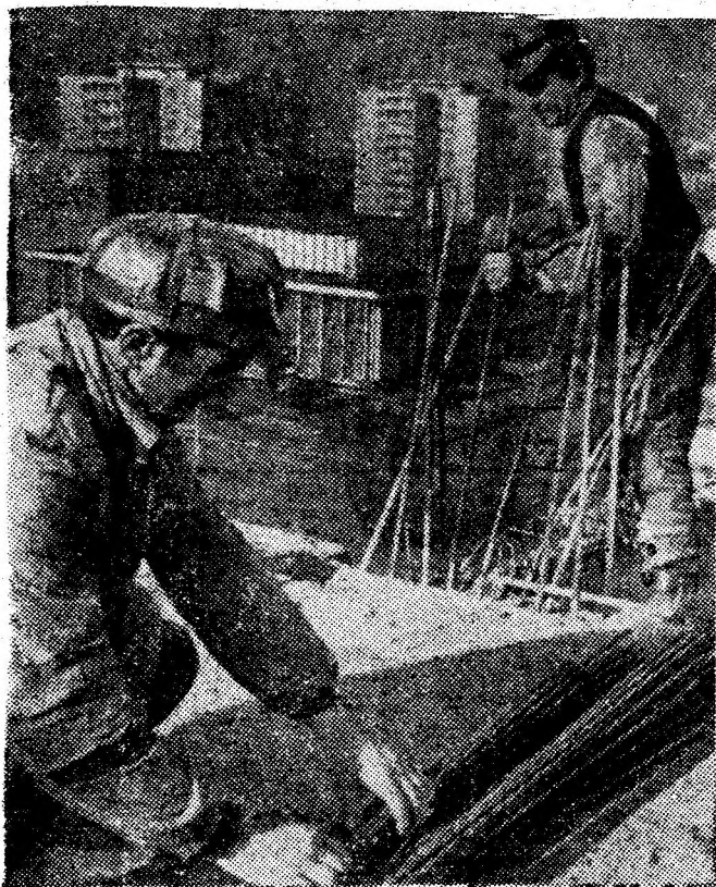
Dulgherii Ion Popescu și Gheorghe Butnaru din brigada condusă de cunoscutul Gogu Neagoe, armează planșeele de etaj ale unui nou bloc din viitorul centru civic al Petrosaniului.
