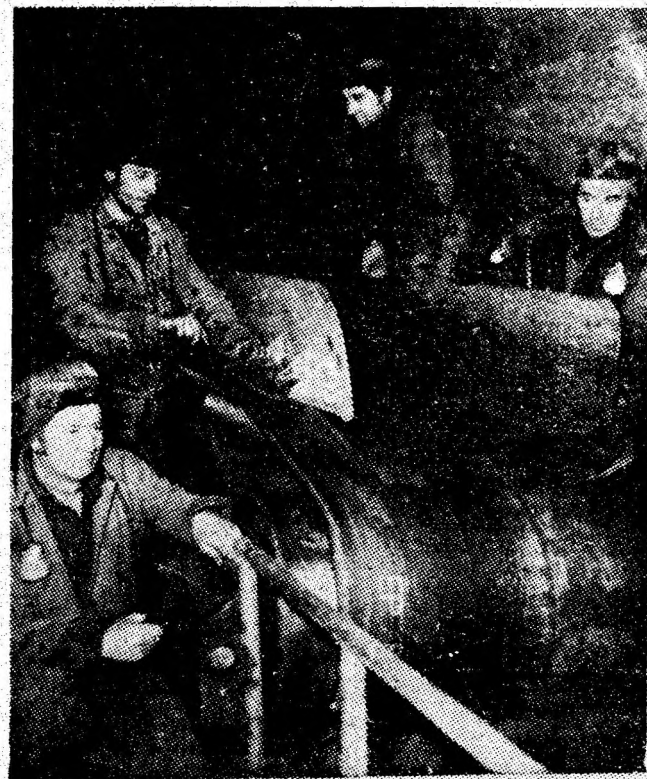
Echipa condusă de lăcătușul Constantin Cimpoiesu, finalizează lucrările de schimbare a roților și benzii de cauciuc, la puțul cu schip al minei Paroșeni. Foto: Ștefan NEMECSEK
