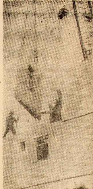
Pe șantierul construcțiilor de locuințe din orașul Vulcan, formația de montori a planșeelor prefabricate, condusă de Nicolae Ion, lucrează cu bune rezultate la viitorul bloc nr. 54 cu două scări, 20 apartamente cu 3 și 4 camere.
