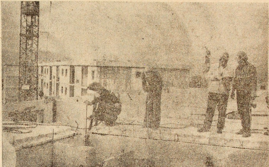
Șeful lotului nr. 2 de șantier Vulcan, Constantin Dumitrescu, verifică montarea corectă a panourilor de prefabricate la blocul nr. 54 cu 2 scări, 20 apartamente cu 3 și 4 camere pe șantierul construcțiilor de locuințe din Vulcan.
