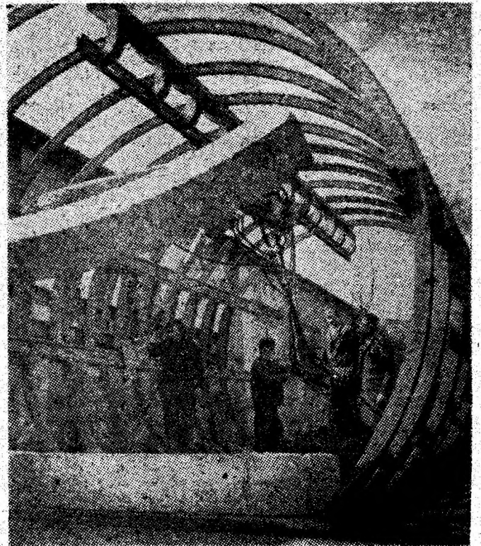
Rod al colaborării dintre proiectanții de la S.S.H. Vulcan și cercetătorii I.C.P.M.C., a fost concepută și realizată mașina hidraulică de montaj panouri de prefabricate din beton armat în lucrările miniere orizontale cu profil mare.
