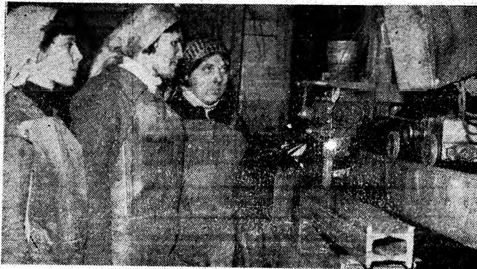
In cadrul atelierului de construcții metalice de la I.U.M. Petroșani, sudorul Georgeta Matei și colegile ei Marieta Turtoiu și Ana Tomulescu, lucrează cu bune rezultate la o modernă mașină de sudat sub flux.
