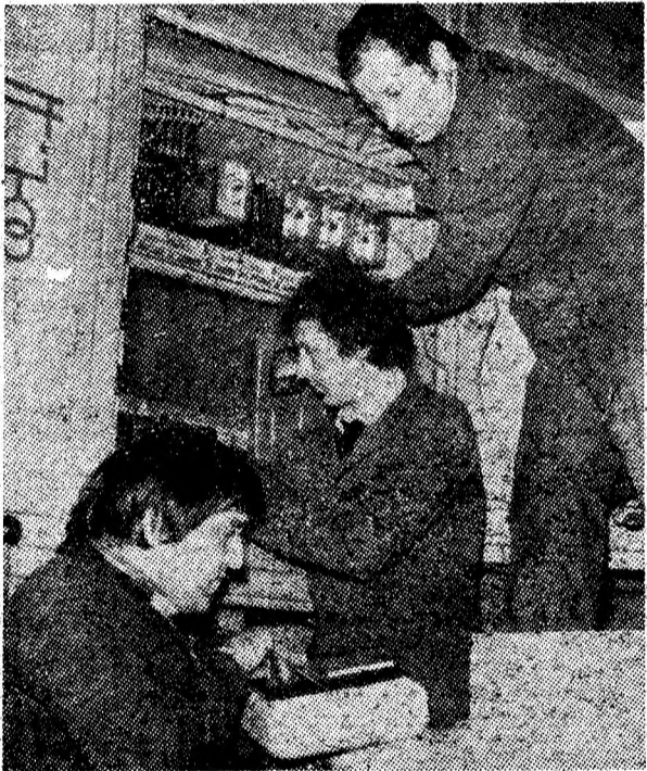
Electricienii specialiști Nicolae Popescu și Constantin Drăguț, alături de ing. Aurelian Serafinceanu, șeful atelierului PRAM-SERVICE de la I.P.S.R.U.E.E.M. Petroșani, pun în funcțiune o celulă defectă din stația de 6 kV de la preparația Petrila.
